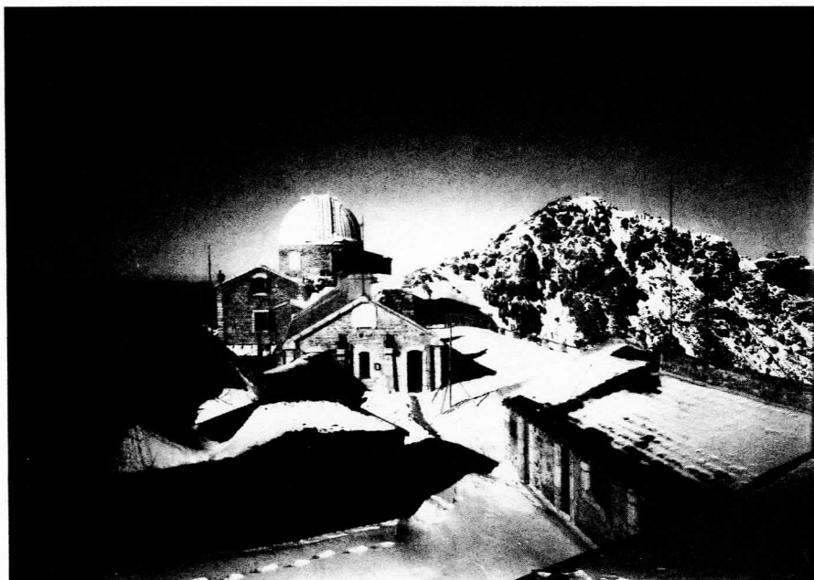
Figure 22 : vue générale (vers l'ouest) de l'observatoire vers 1920. On remarquera la présence d'un tunnel de bois extérieur (qu'on ne mettait en place que pour l'hiver) reliant le bâtiment Nansouty au pavillon de la lunette d'Eichens. Le sommet du Pic du Midi (2877 m) est visible à droite de la photographie ; on aperçoit le signal géodésique.
