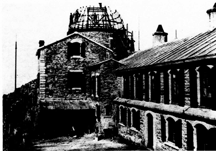
Figure 18 : fin 1906 : on assemble la coupole Baillaud (8 m de diamètre) dont la charpente fut conçue et construite tout d'abord à l'observatoire de Toulouse (en haut), au sommet du Pic du Midi (en bas). La coupole et les instruments furent transportés depuis la vallée à dos de mulets puis d'hommes, grâce à l'aide des artilleurs de Tarbes. Au premier plan du cliché du bas, on aperçoit la "maison de Toulouse" et le bâtiment Nansouty devant la coupole en cours d'érection. (Documents OPMT, l'image du bas date du 28 septembre 1906)
