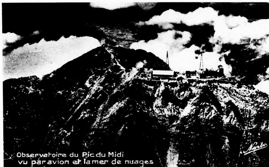
Figure 25 : vue aérienne de l'observatoire vers 1940. Le bâtiment Nansouty a été élargi et la toiture refaite (1937) ; on note, devant le blockhaus, la présence d'une nouvelle construction : il s'agit du bâtiment Dauzère achevé en 1935. Le sommet du Pic est à gauche ; on distingue le chemin en lacets grimpant des Laquets.
