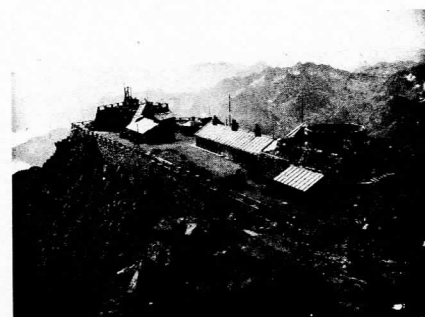
Figure 16 : l'observatoire en 1906. La grande terrasse nord est pratiquement achevée ; la maçonnerie de la future coupole Baillaud est presque terminée, ainsi que l'aménagement du terrain au voisinage. On aperçoit, devant la grille d'entrée, une petite cabane de bois destinée à servir d'abri aux touristes.
