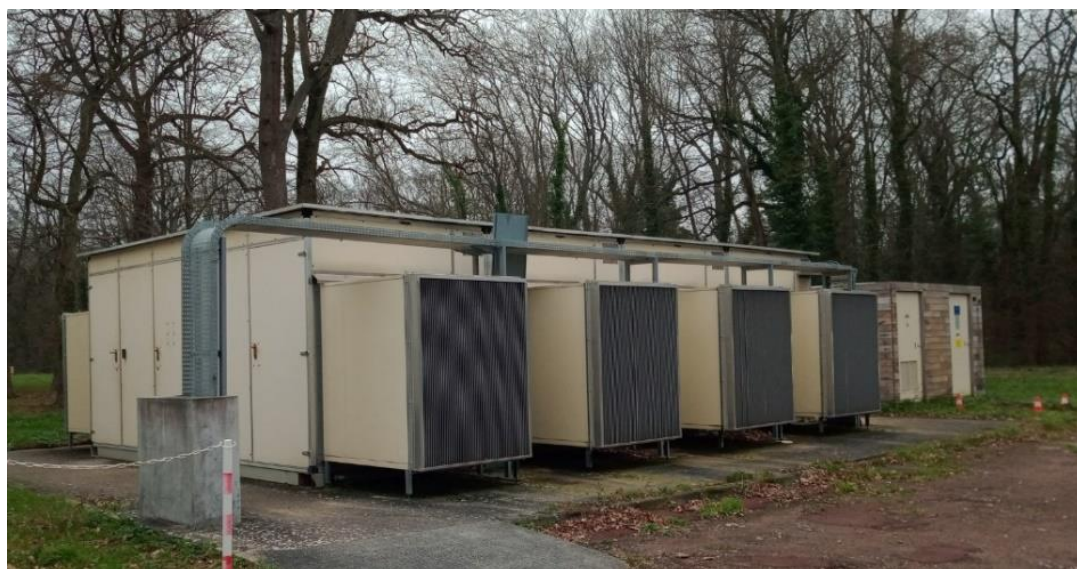
Figure 41 : Le conteneur MesoPSL à Meudon et son système de ventilation (document de l'auteur)
