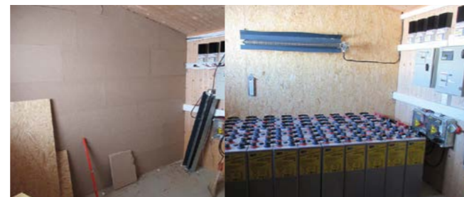
Remplacement du parc batterie
