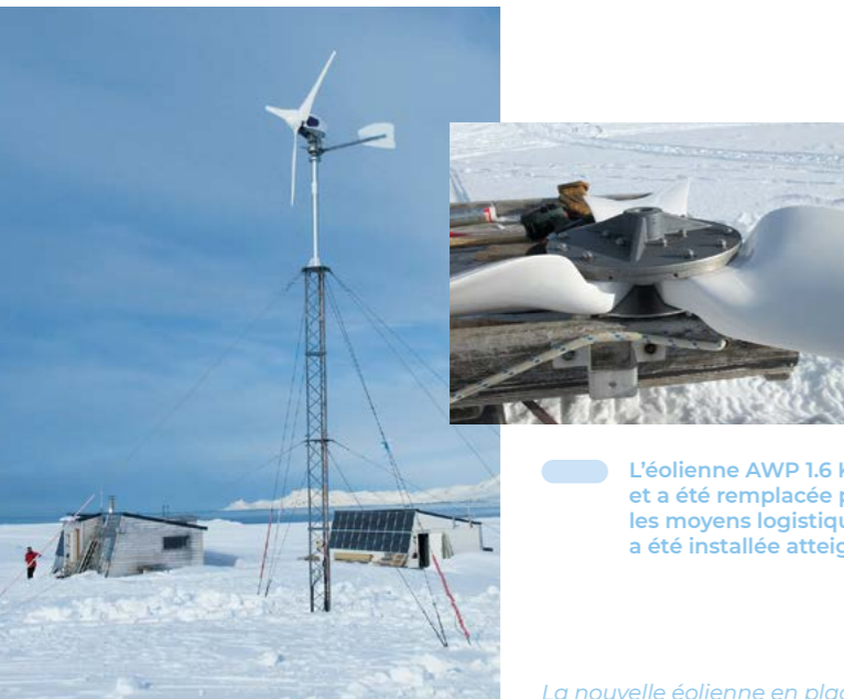
La nouvelle éolienne en place
