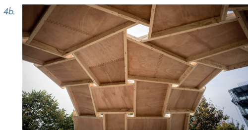
Figure 4. Nexorade contreventée par des panneaux plans 4a. Usinage robotisé au sein de Build'In ; 4b. Pavillon © Tristan Gobin/HAL Robotics Ltd.
