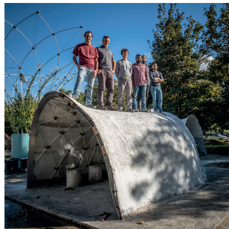
Figure 3. La courbure permet à cette coque mince en béton de porter une charge accidentelle équivalente à son poids avec un élancement proche de 1/250 © Stefano Borghi/École des Ponts ParisTech.
