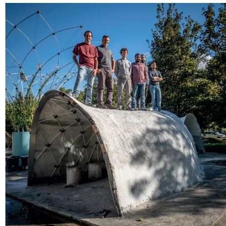
Figure 3. La courbure permet à cette coque mince en béton de porter une charge accidentelle équivalente à son poids avec un élanement proche de 1/250 © Stefano Borghi/École des Ponts ParisTech.
