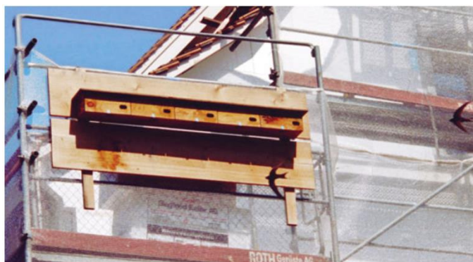
Figure 11 : Nichoirs temporaire sur échafaudage (Scholl 2016)
