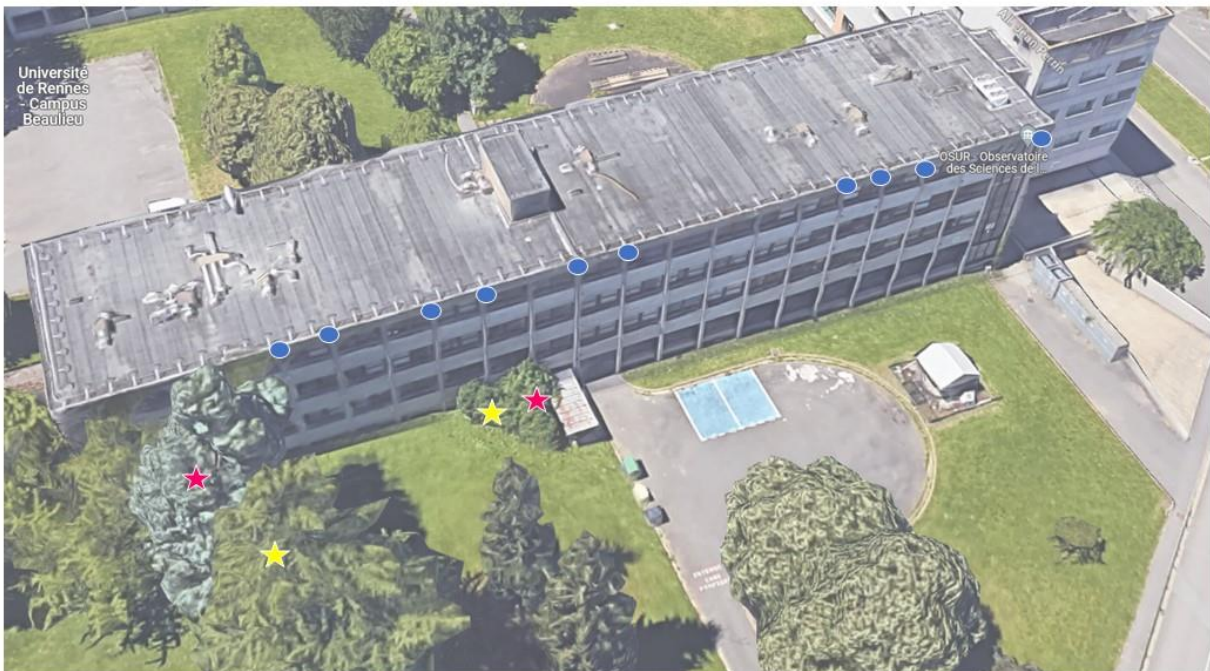
Bâtiment 15 : Façade Est
