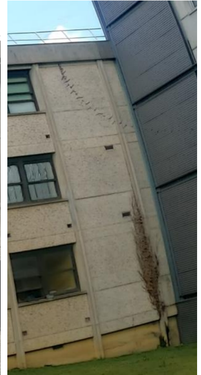
Figure 14 : Entrée de nid qui n'est pas au-dessus d'une fenêtre (Bâtiment 14A Nord-Est)
