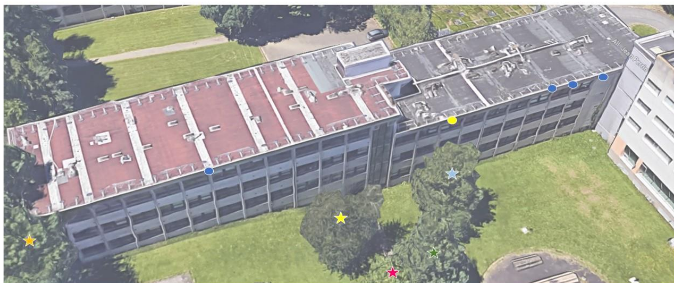
Bâtiment 14A : Façade Est
