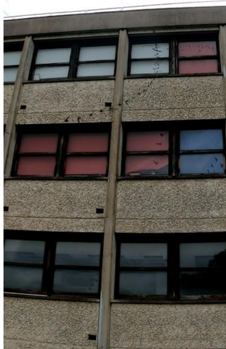
Figure 13 : Entrée de nid au milieu d'un motif de fenêtre (Bâtiment 14A Nord-Ouest)
