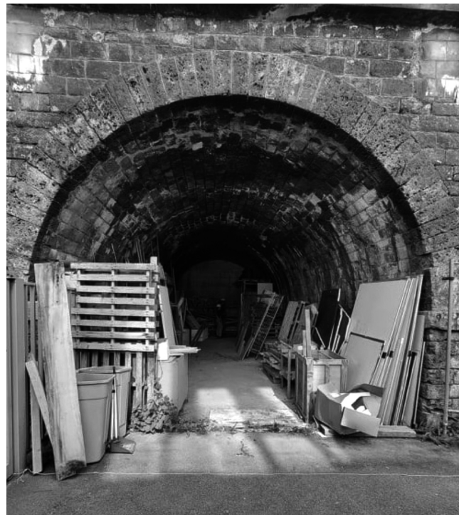
Figure 4. La voûte de stockage. Source: « Cycle de la matière ».
