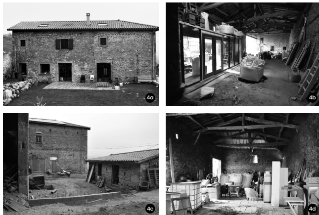
Figure 4. Ferme de F.B. et E.B., Monts du Lyonnais (Rhône), en janvier 2021 : transformations réalisées, en cours et projetées. 4a : la maison rénovée en 2015, façade extérieure ; 4b : le moulin à céréales auto-construit en 2019 sous le chapi ; 4c : les travaux de terrassement en cours (auto-réalisation) ; 4d : la grange, un projet dont on n'a pas de le temps de s'occuper. Source : photos équipe de recherche « Fermes U+ ».
