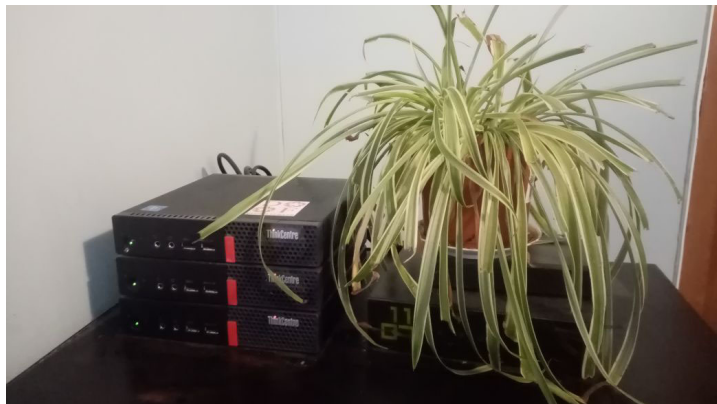
FIGURE 1. Ancienne grappe de production de Lyon : seul le sur-arrosage peut nous couler. Pour plus d'information sur notre infrastructure : https://guide.deuxfleurs.fr/infrastructures
