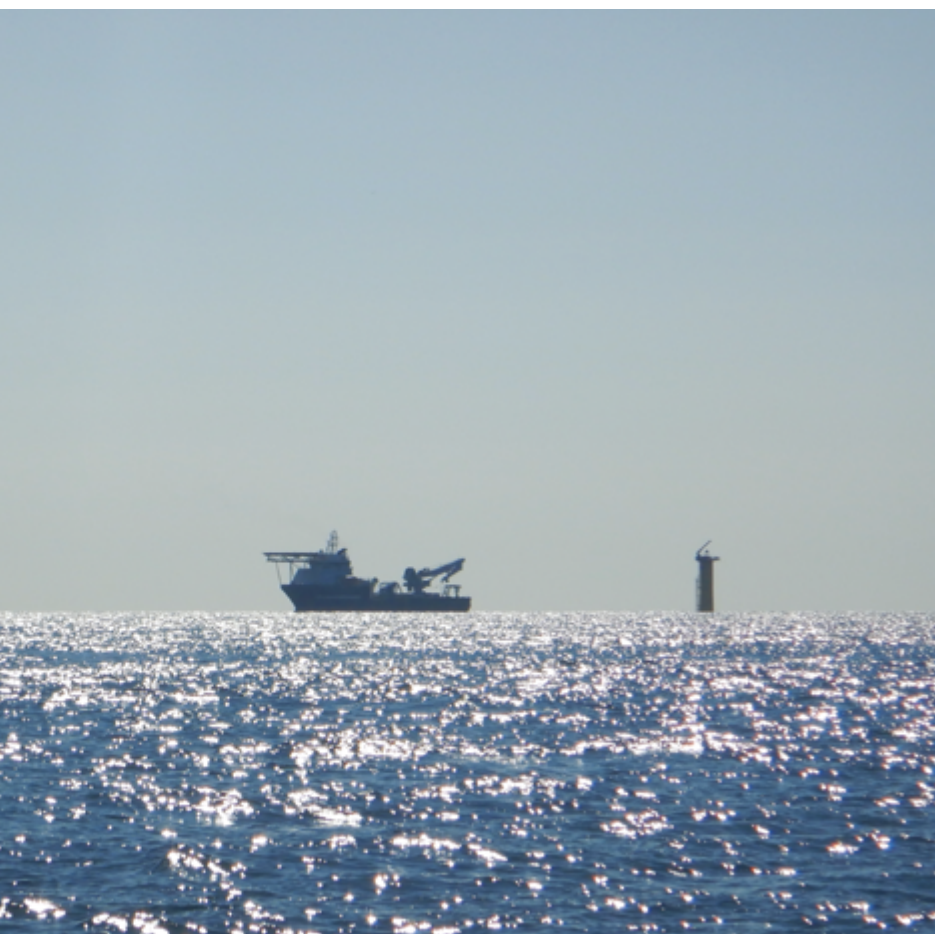
← Installation d'une ferme éolienne offshore.
