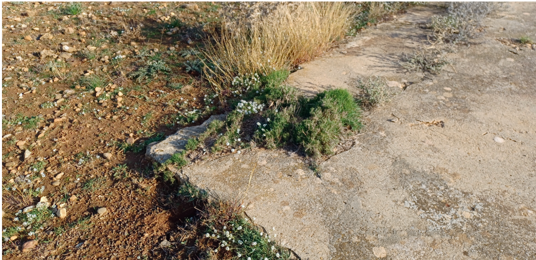
Pieds de brachypodes rameux ( Brachypodium retusum (Pers.) P. Beauv.), espèce dominante de la steppe de Cévennes, colonisant spontanément les dalles de béton.
