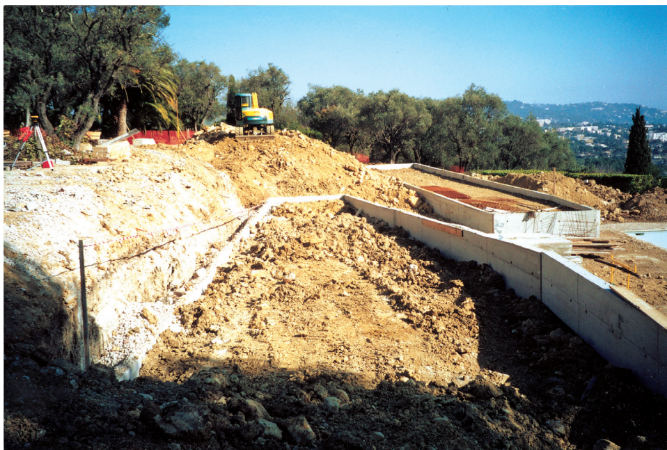
1. Mougins (Alpes-Maritimes), terrassements à partir des nouveaux murs de retenue, 2004. © P. Cribier.
