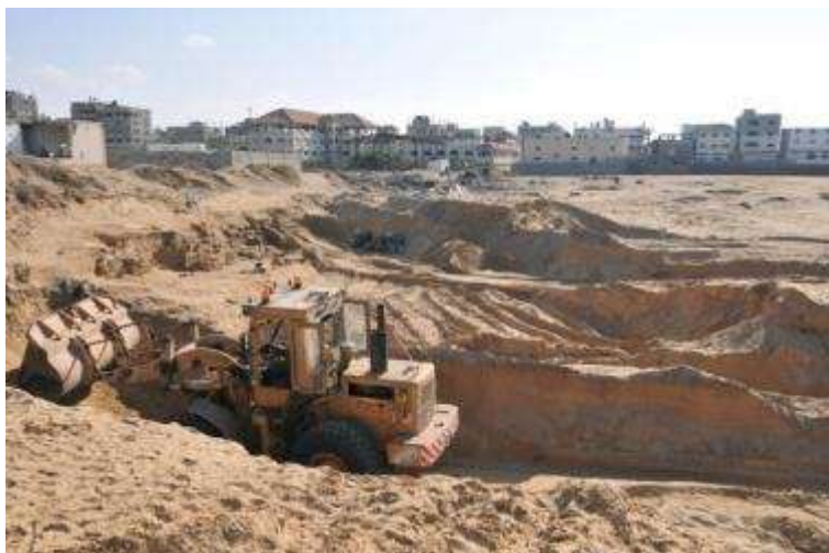
Figure 22: chantier B, vue vers l'Est, Photo J. -B. HUMBERT, 2012.
