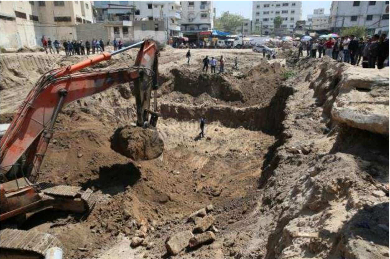
Figure 27: creusement des fondations d'un nouvel immeuble, 2015 (Photo S. Nègre)
